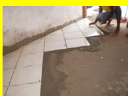
Piso de nuestra casa siendo colocado.
